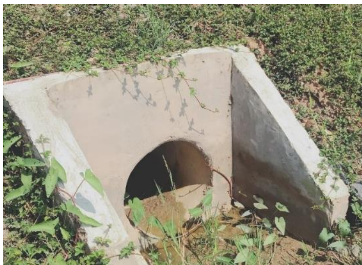
Hình 8. Cửa xả nước mưa đã xây dựng
