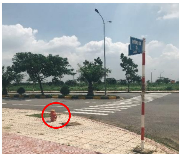
Hình 9. Họng chữa cháy tại đường số 5 khu nhà liền kề
