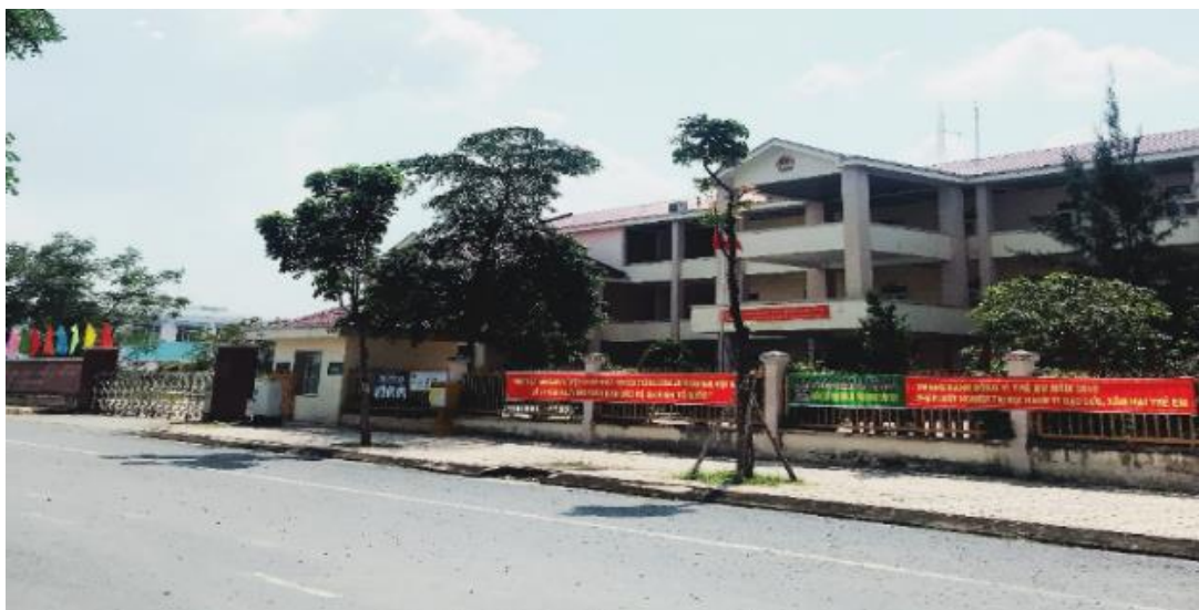
Hình 7. Công trình hành chính – UBND phường Long Hưng đã hoàn thành
