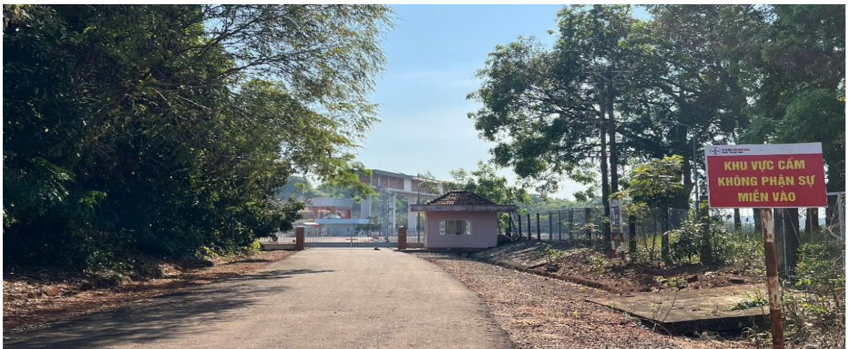
Hình 1.9: Chốt bảo vệ Đập tràn
