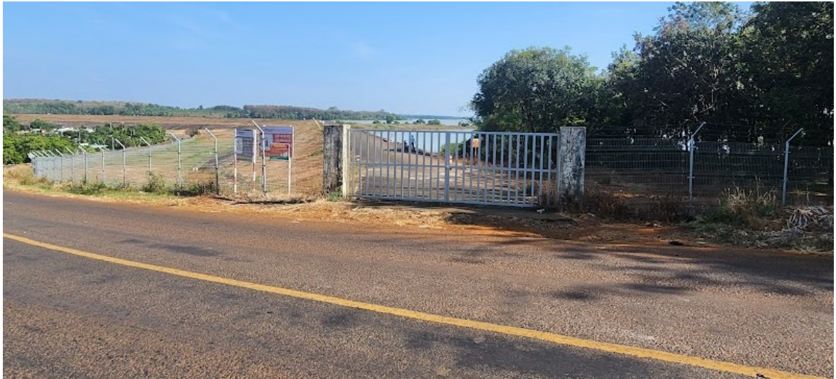
Hình 2.7: Hàng rào sắt + cổng sắt khóa đường biên khu vực đập Bình Đức
