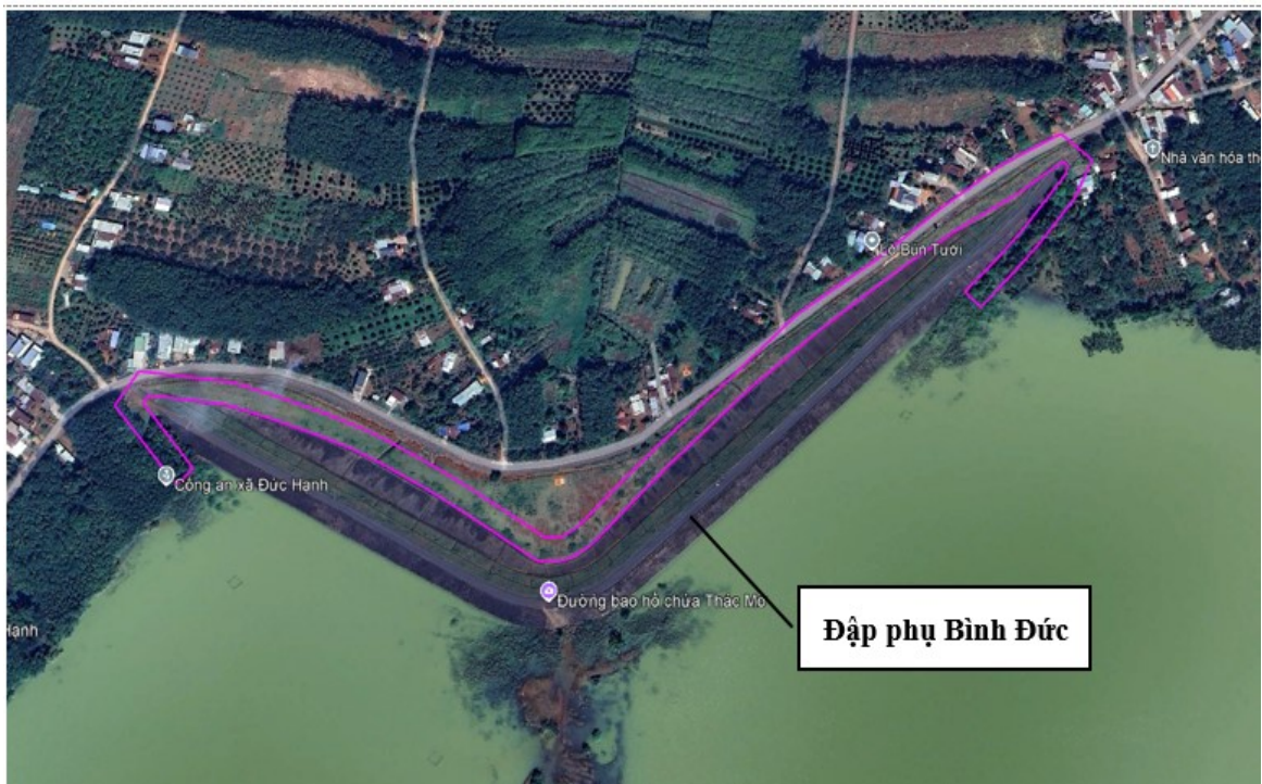
Hình 2.6: Phạm vi hành lang cấm mọc phụ cận đập phụ Bình Đức, khoảng cách 20m từ chân đập. Toàn bộ đường biên được xây dựng hàng rào thép + công sắt khóa 2 đầu
