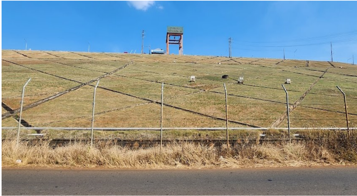
Hình 2.5: Đường biên hành lang bảo vệ cụm đập + tuyến năng lượng, + nhà máy đã xây dựng hàng rào lưới sắt bảo vệ. Tại các lối ra vào chính bố trí chốt kiểm soát cố định
