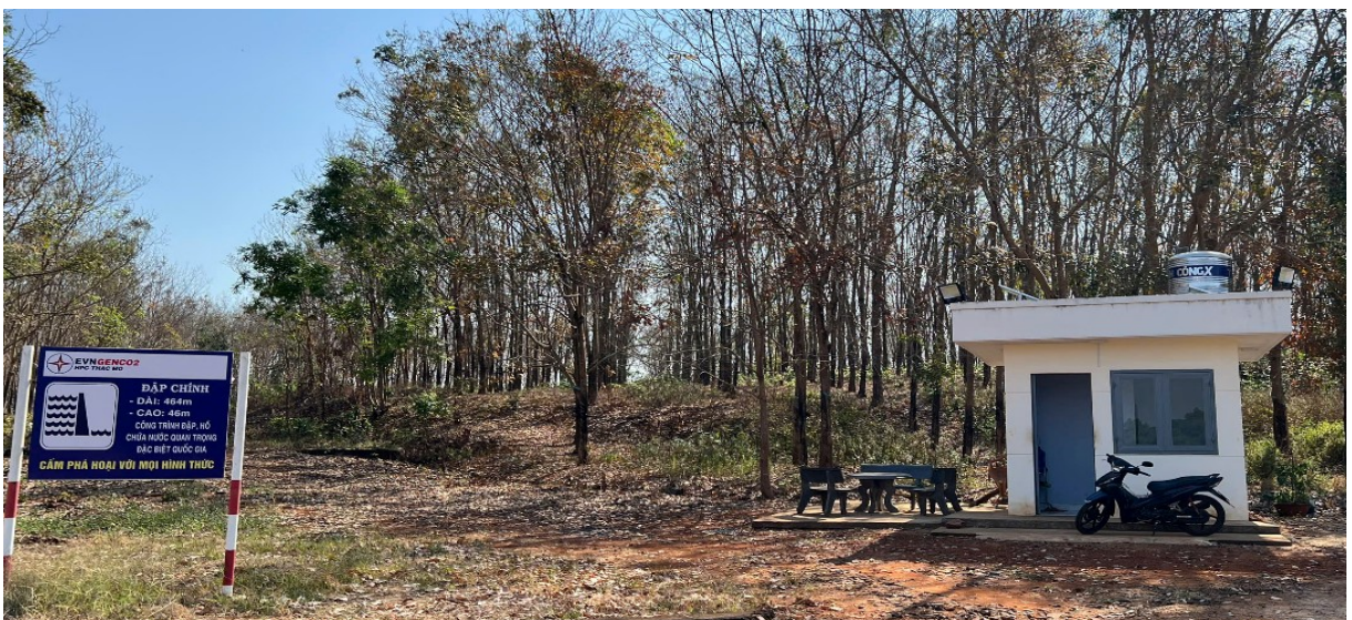
Hình 1.10: Chốt bảo vệ Đập chính
