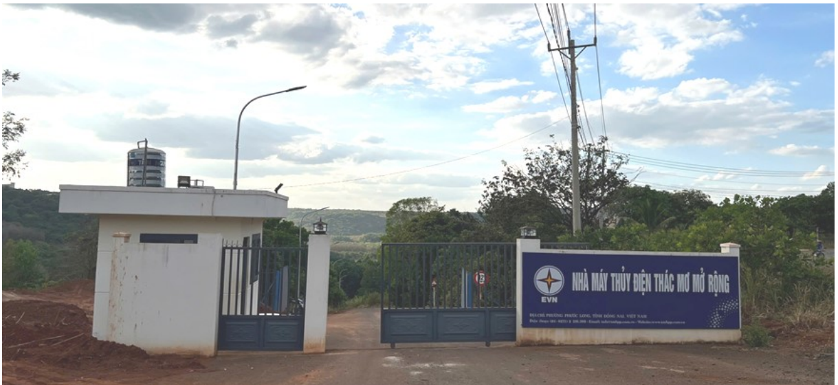
Hình 1.6: Chốt bảo vệ cổng chính vào MNTĐ Thác Mơ mở rộng
