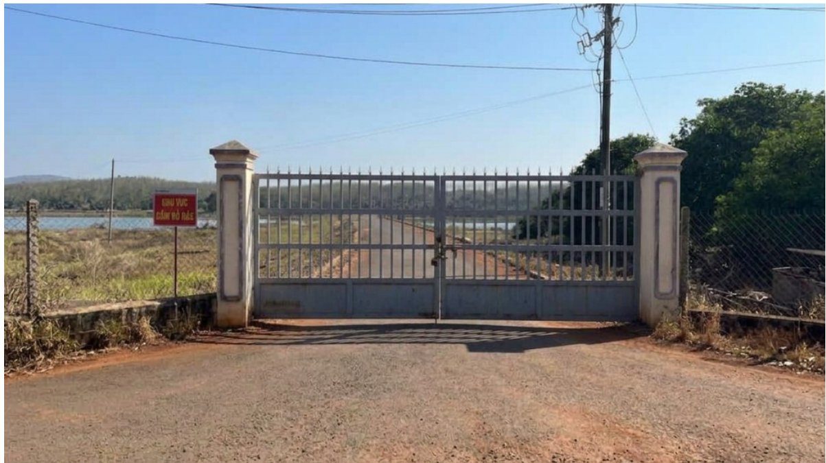
Hình 2.10: Hàng rào sắt + cổng sắt khóa đường biên khu vực đập Phước Tín
