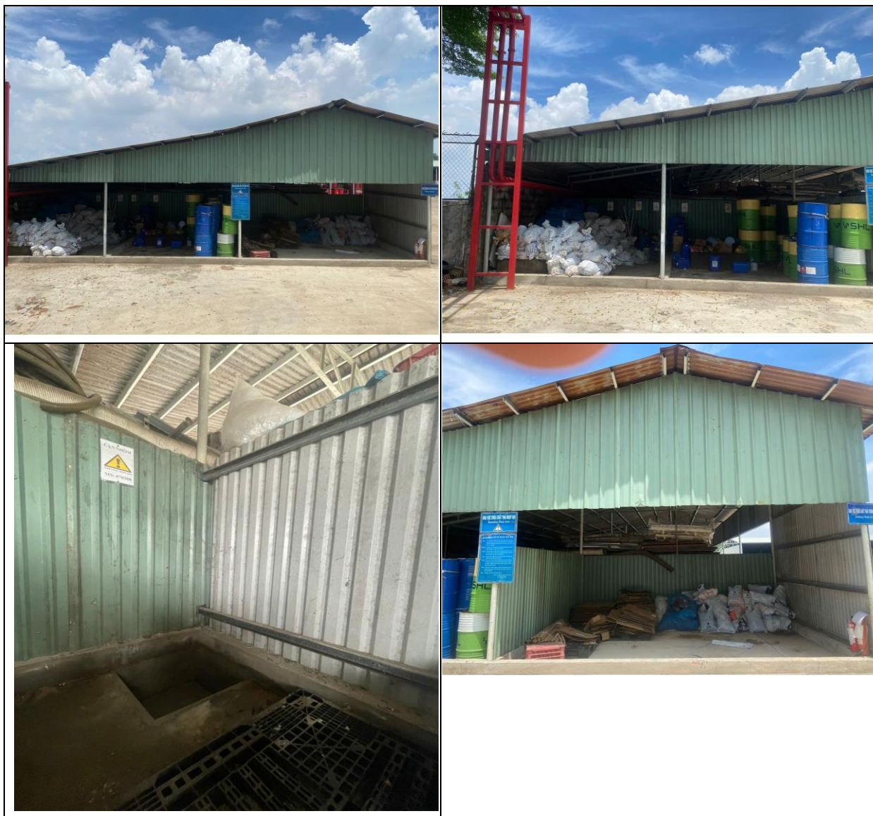
Hình 3.12. Hình ảnh khu vực lưu chứa chất thải tại cơ sở
